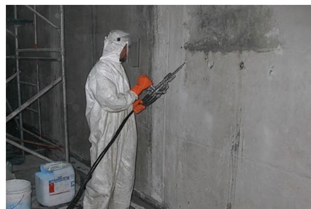
Aplicação do sistema de poliuretano flexível
