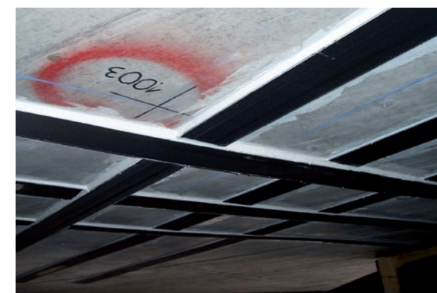
Resultado final da aplicação do MC-CarbonFiber Lamella
