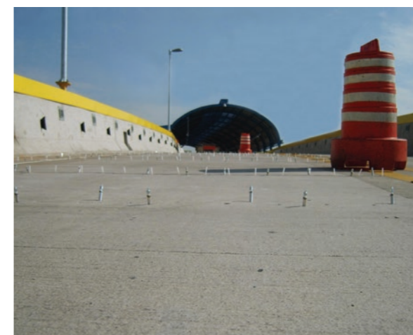
Aplicação do sistema de resina epóxi
