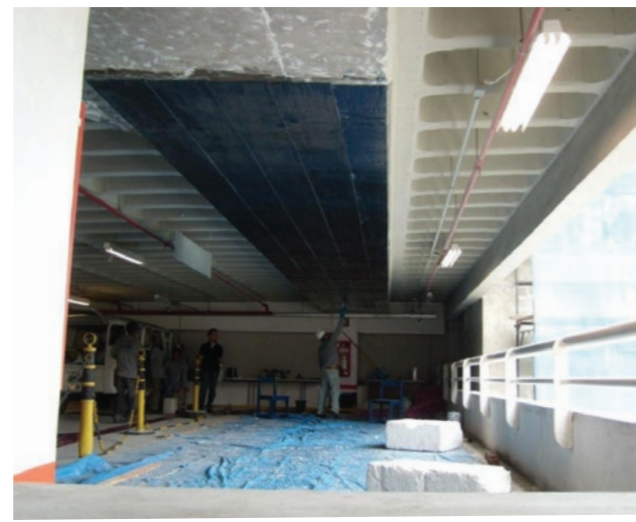
Aplicação da resina de saturação MC-DUR 1200 VK
