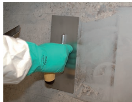
Aplicação da ponte de aderência MC-CarboSolid 1209 TX
