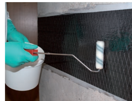
Aplicação da resina de saturação MC-DUR 1200 VK
