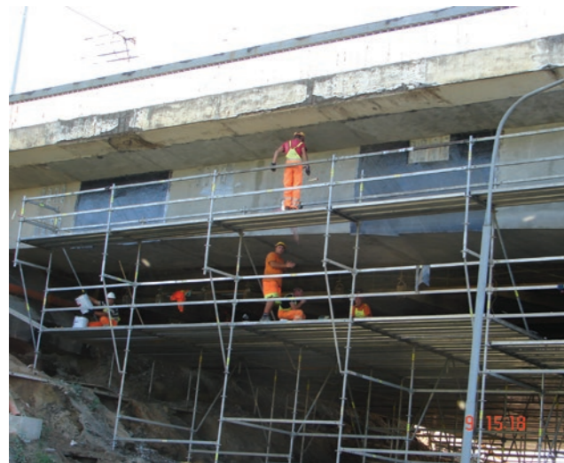
Aplicação da manta de fibra de carbono MC-CarbonFiber Sheets
