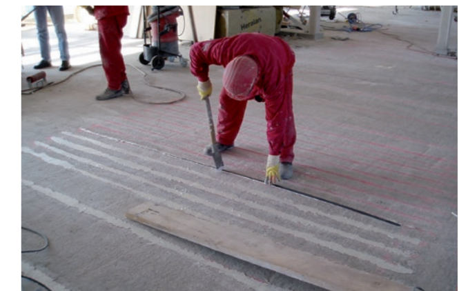
Aplicação de lâmina de fibra de carbono MC-CarbonFiber Lamella
