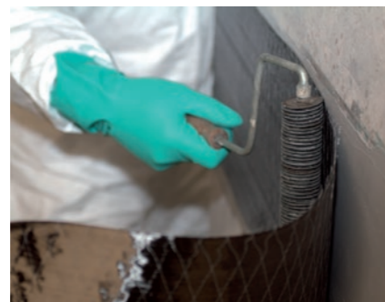
Aplicação da manta de fibra de carbono MC-CarbonFiber Sheets
